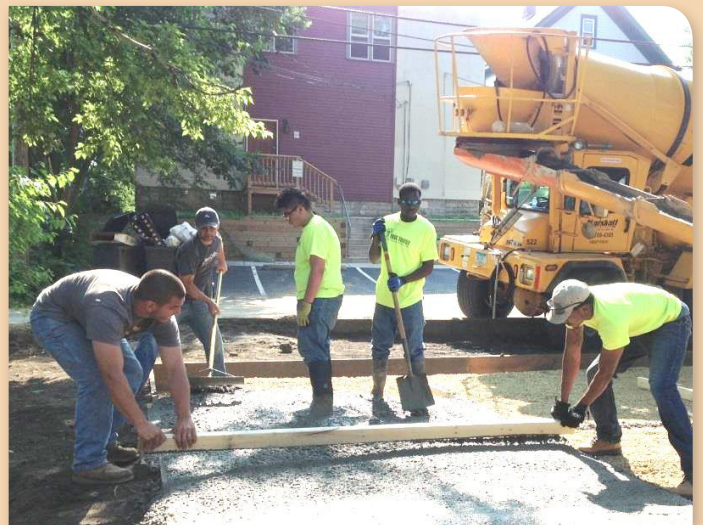
Carlos, Jeremy, and Ty pour concrete.
