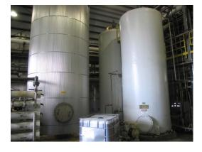
Ethanol Enzyme Tank & Liquefaction Tank
